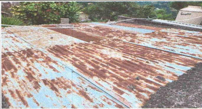
Foto1: Sustitución de lámina.
