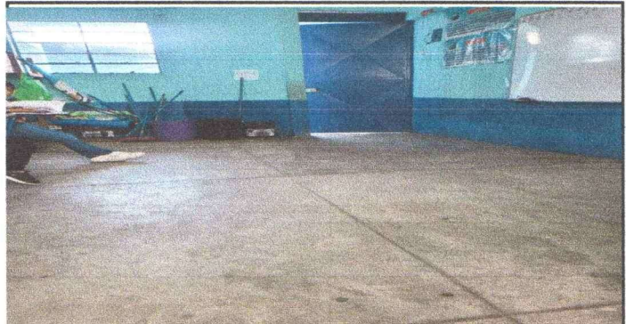
Foto 4: Sustitución de piso de cemento líquido.
