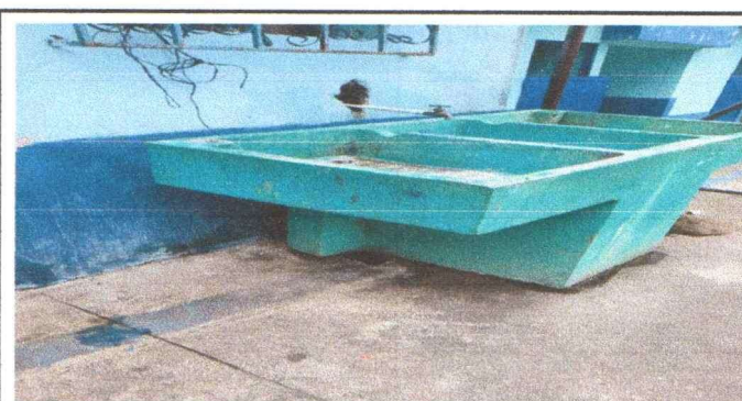
Foto 12: Sustitución de pila de cemento de dos lavaderos.
