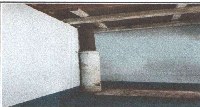
Foto 11: Sustitución de chimeneas de concreto.
