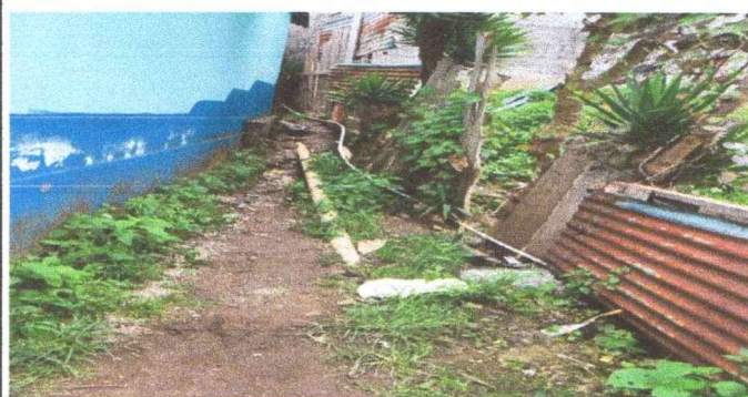
Foto 8: Sustitución de tubería PVC línea principal de aguas negras.
