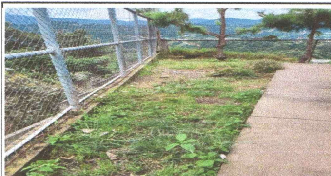
Foto 10: Reparación de planchas de concreto de patio.
