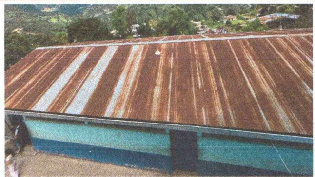
Foto 2: Sustitución de lámina y capotes.
