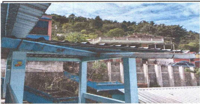
Foto 5: Sustitución de canal y bajada de agua pluvial
